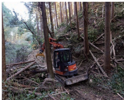
小型のグラブブル、バックホウ等の林業機械が通れる幅の作業道をつくりながら伐木、は積みをしていく。
