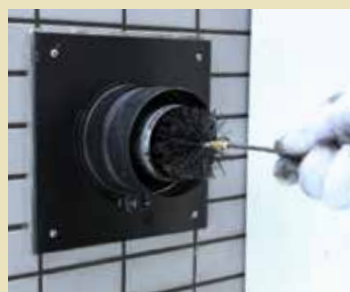
壁貫通部給排気管クリーニング
